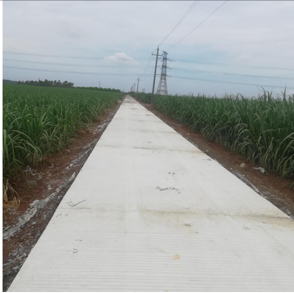
项目东面道路
