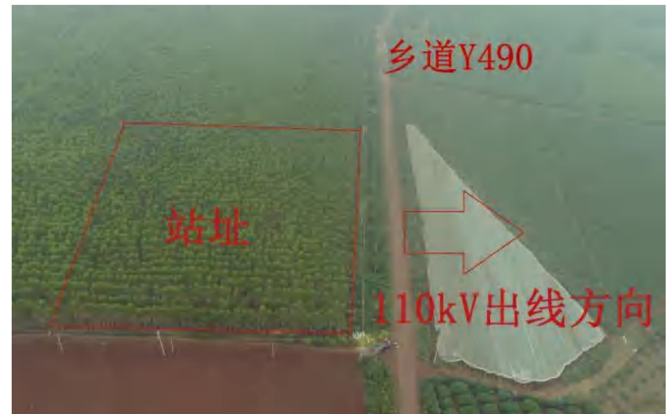
图 3.1-4: 站址现状照片 02
