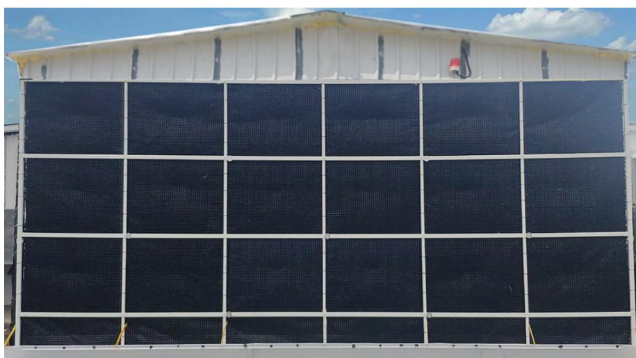
图 4-1 除臭装置示意图
