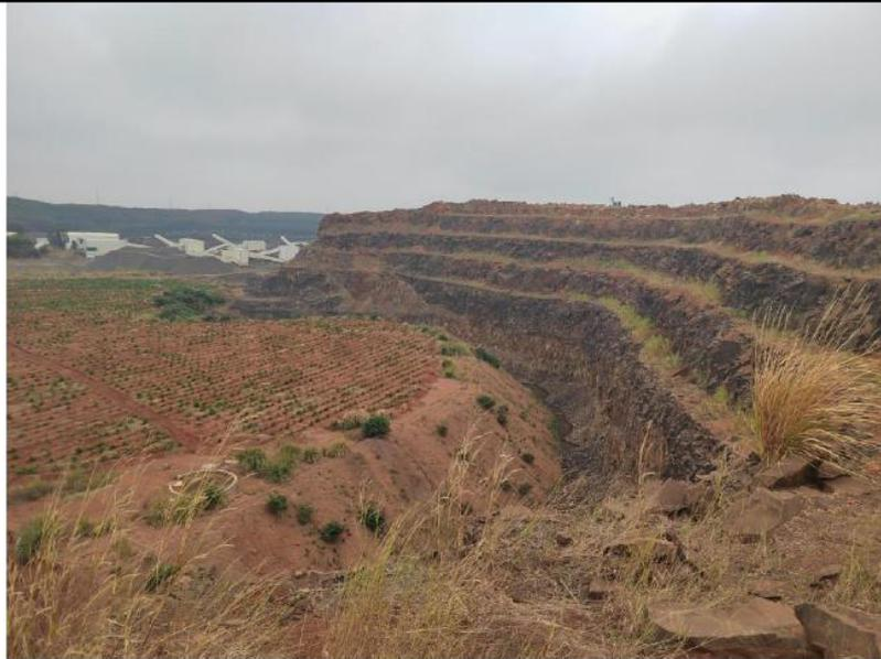
图 3-3 矿山闭坑台阶及复绿照片
