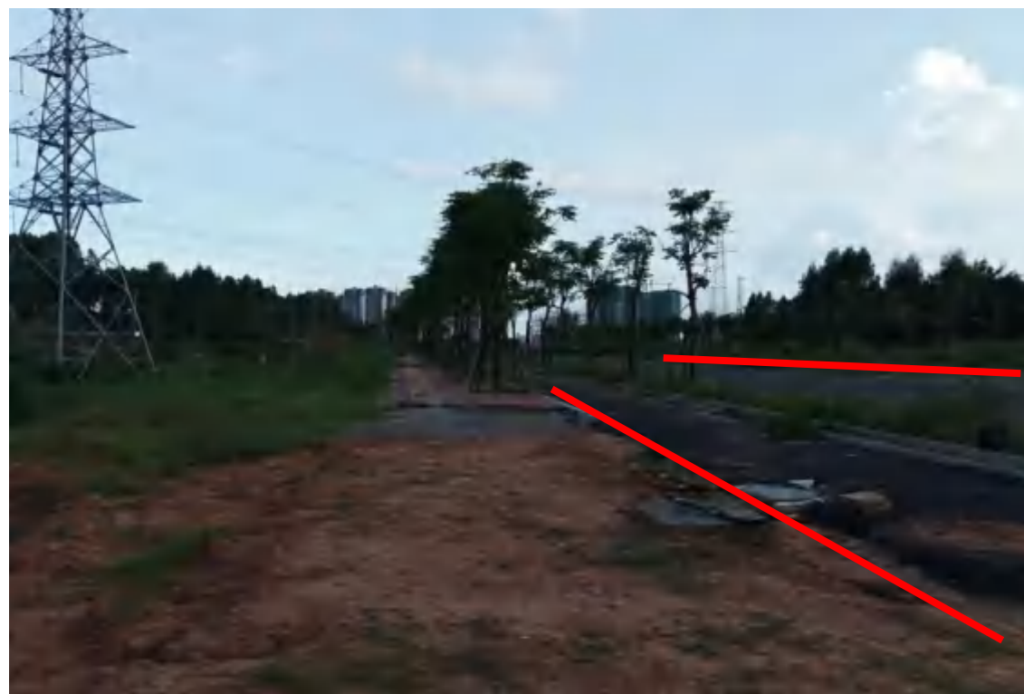
正在施工的清端五路
