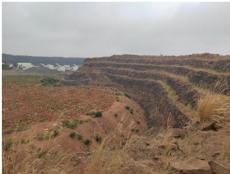
图 3-3 矿山闭坑台阶及复绿照片
