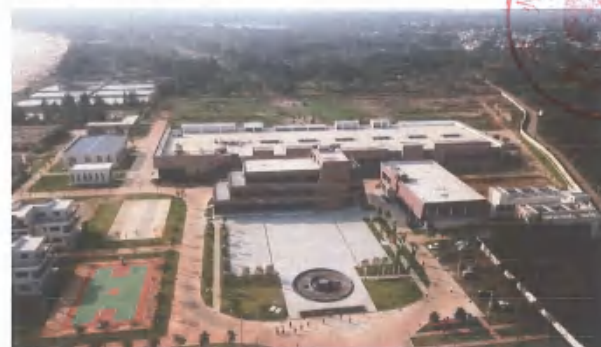
2. 70.2 亩建设用地现状照片
