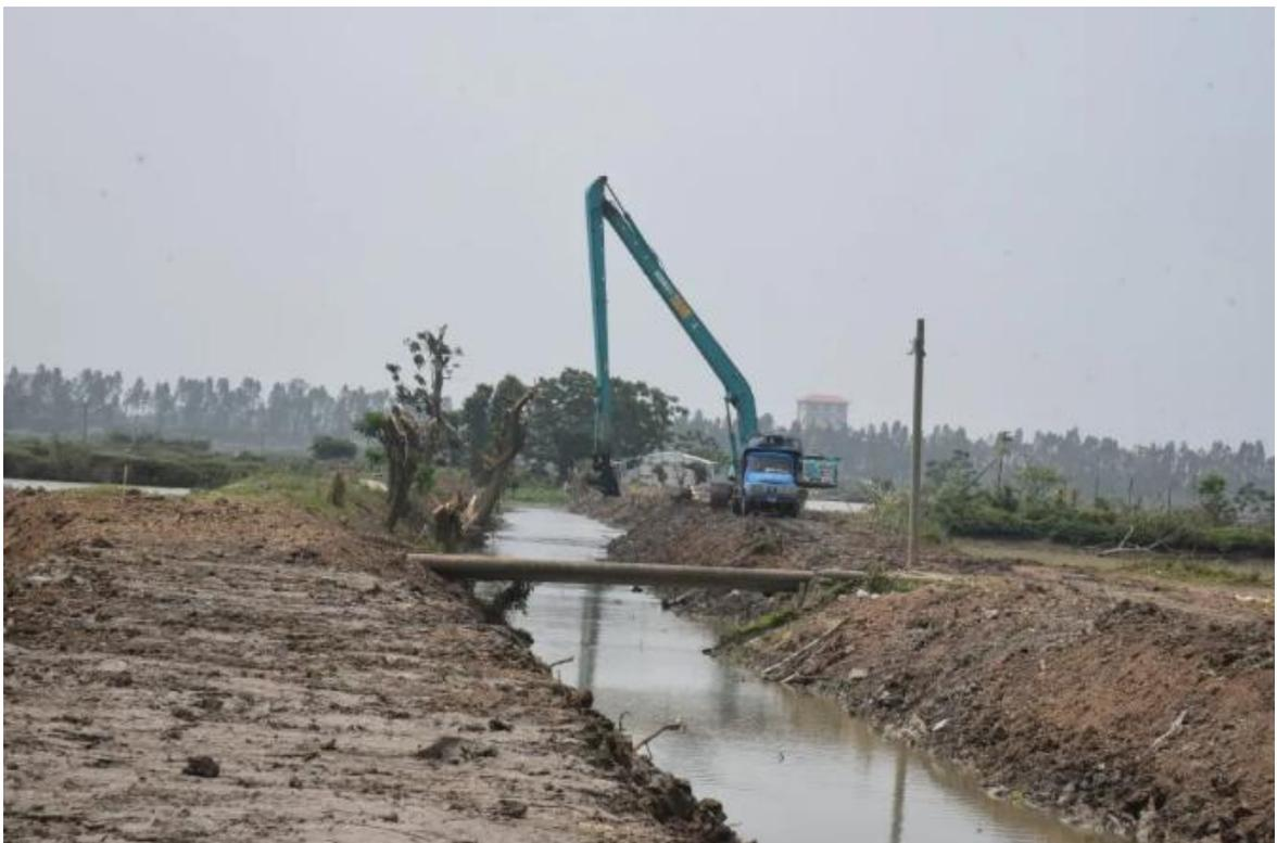
仪式结束后，清淤工程首先在青年运河陈家桥河段和附城镇浦西村启动。几台挖掘机轰鸣作业，粗壮的机械臂高高扬起，挥舞着挖斗，将沟渠内沉积的淤泥、石块、枯枝等杂物垃圾一一进行铲除，为河道水沟“疏经活络”。春日暖阳下，清淤后的灌溉水渠重焕生机。
