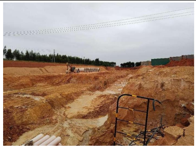
厂址北侧（规划二路）
