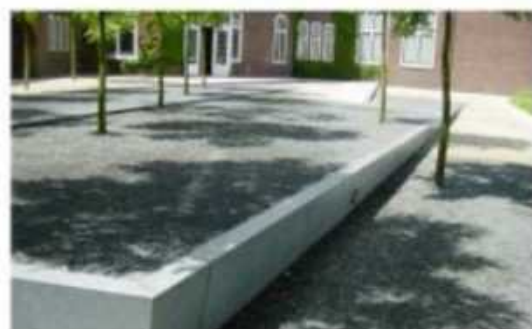
基地表层渗透 透水混凝土及铺地
