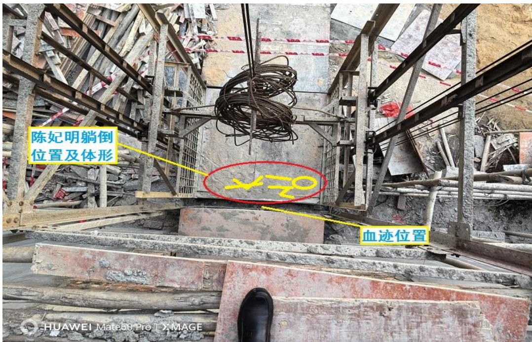
图 8 施工升降机二楼层站入口俯视情况
