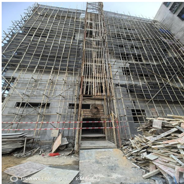
图 4 事发自建房正面（北向）外观
