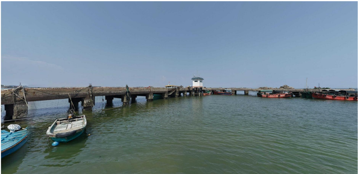
图 1.6.2-1d 流沙港渔业码头现状照片（码头南水域）
