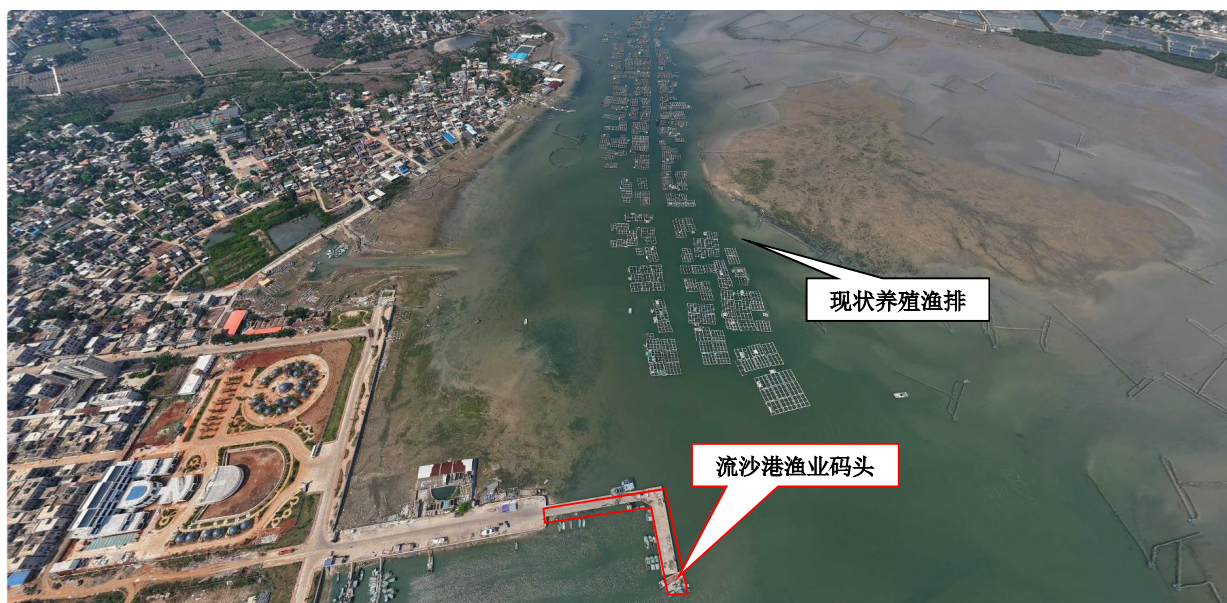
图 1.6.2-1b 流沙港渔业码头现状照片（码头北面）
