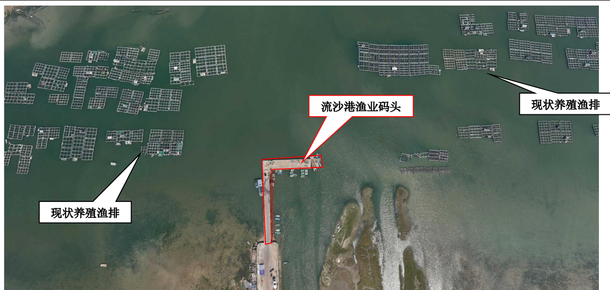
图 1.6.2-1a 流沙港渔业码头现状照片（俯视图）
