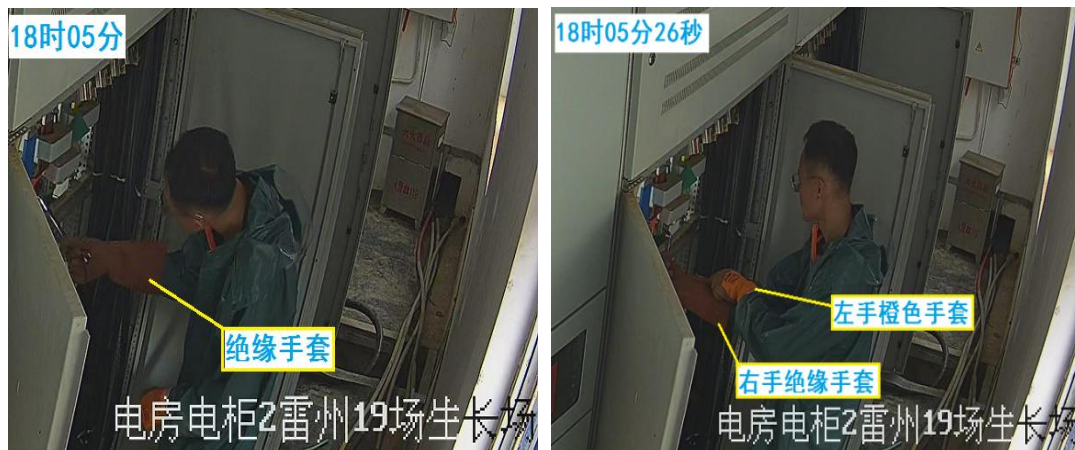
图 13 紧固作业开始时符耀威手套佩戴情况
