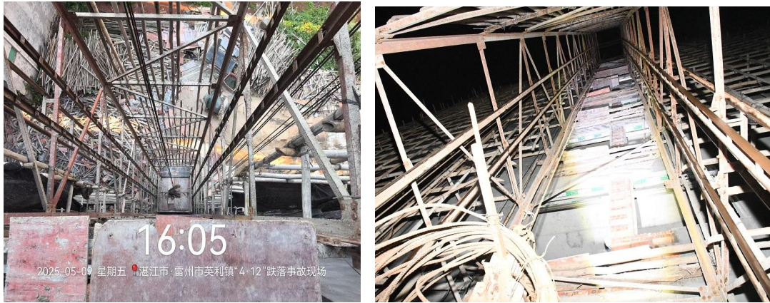
图 7 施工升降机通道六楼俯视、地面仰视内部情况
