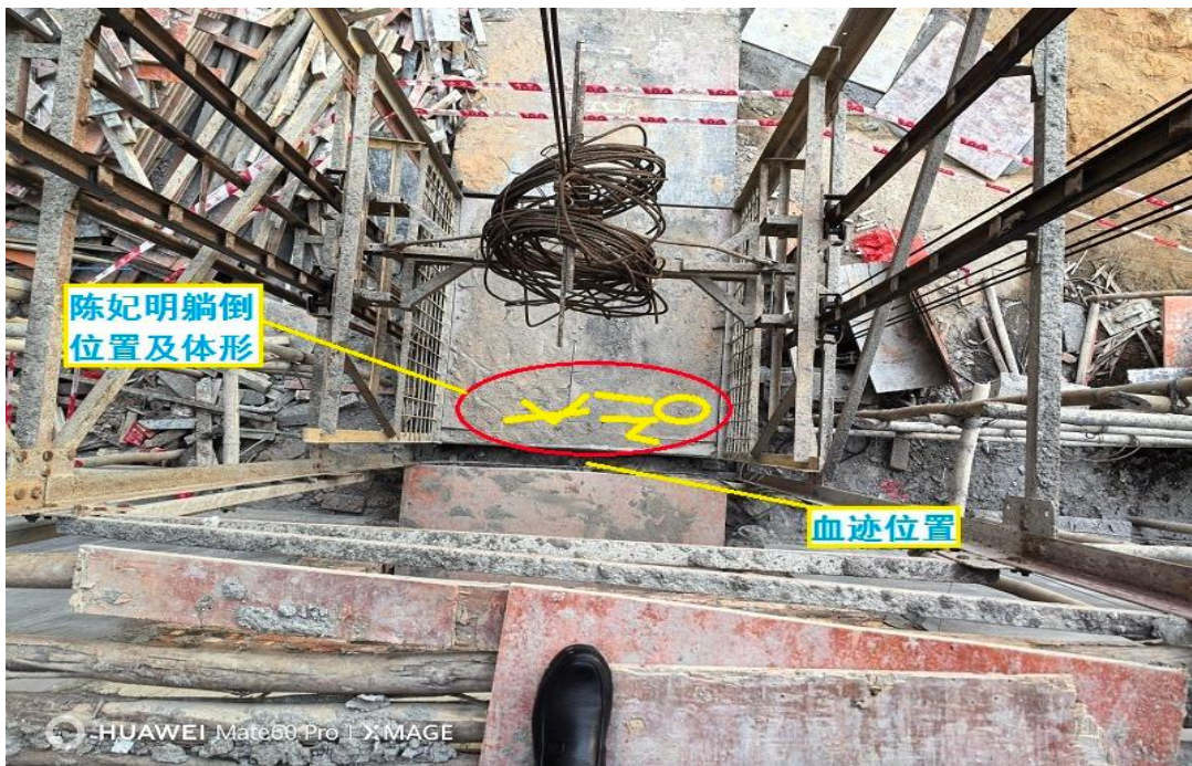
图 8 施工升降机二楼层站入口俯视情况
