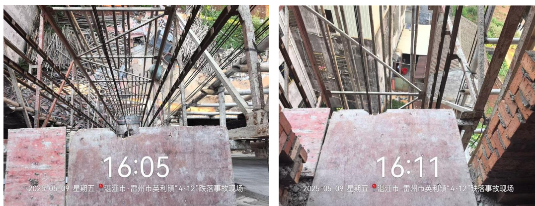
图 10 六楼升降机层站入口情况
