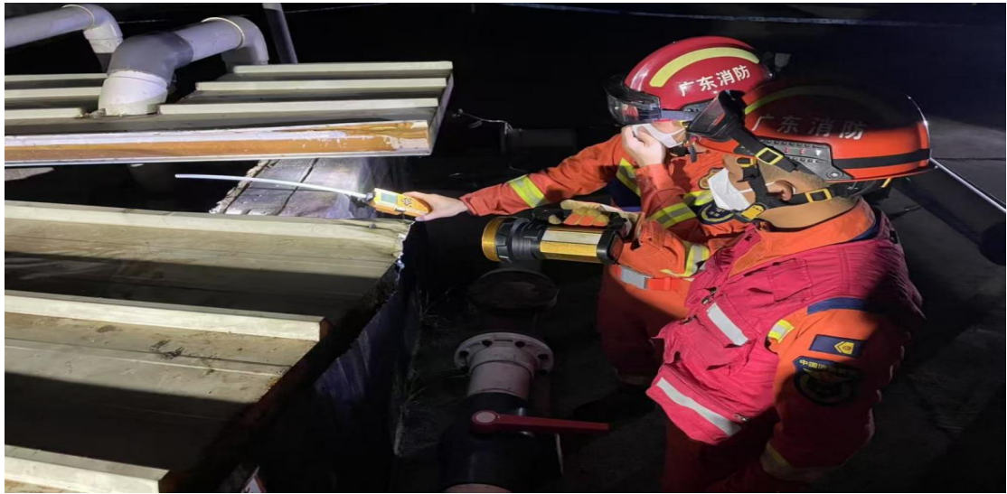
图 10 救援人员救援时检测中转池池面气体浓度含量情况
