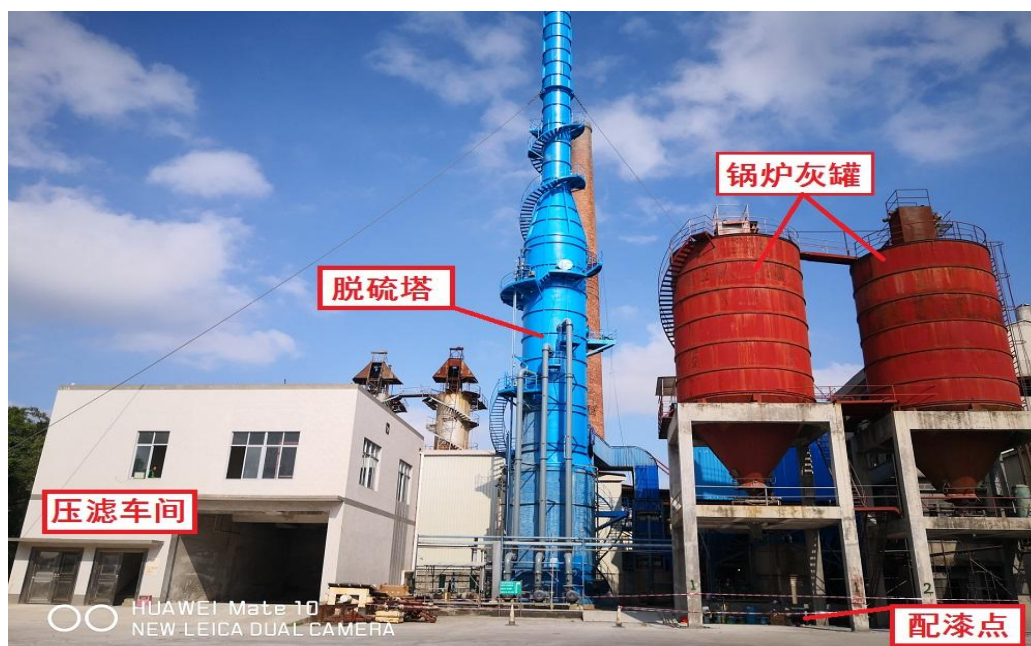
图 1 脱硫塔防腐施工现场情况
