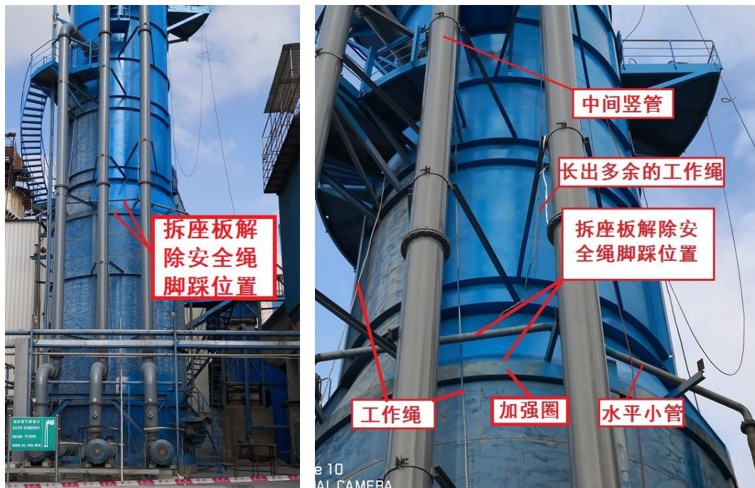
图8 当事人杨春运（死者）转换作业区位置示意；图9 转换作业区时局部大图
