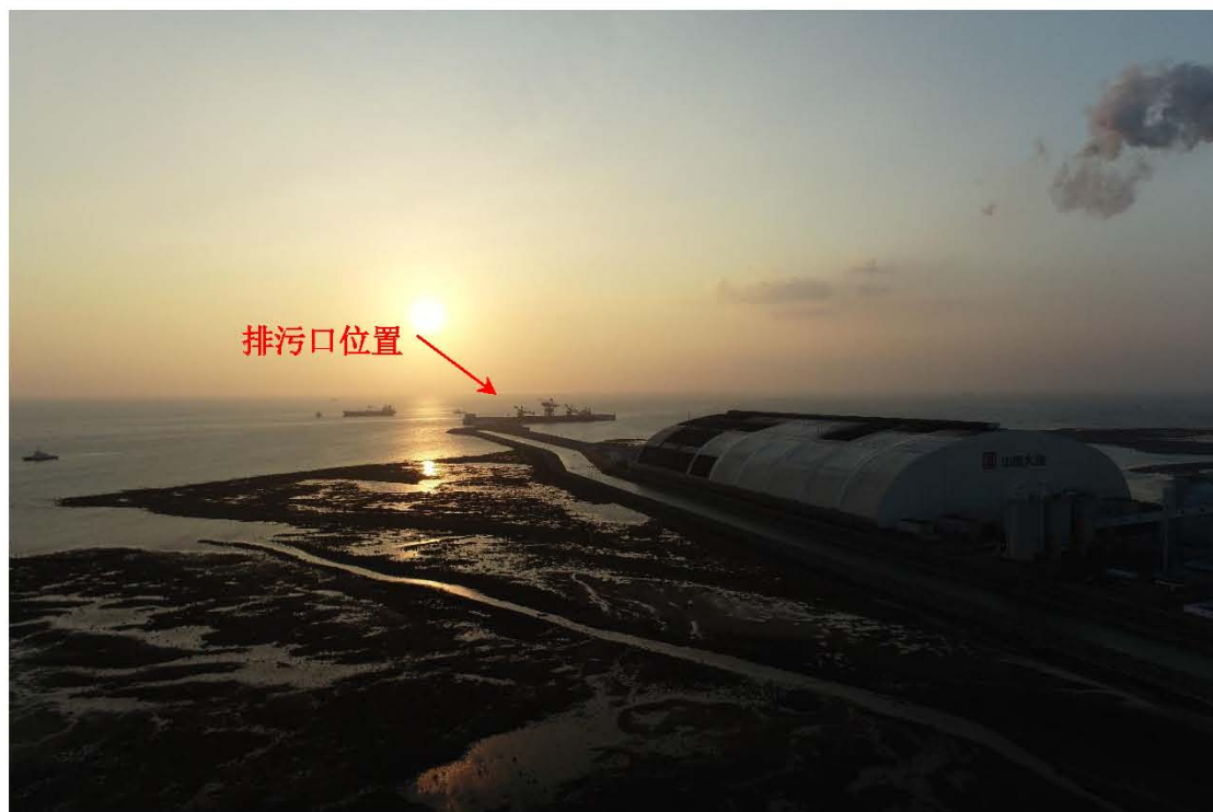
图 5.3.5-6 本项目污水管道拟铺设区域航拍照片
