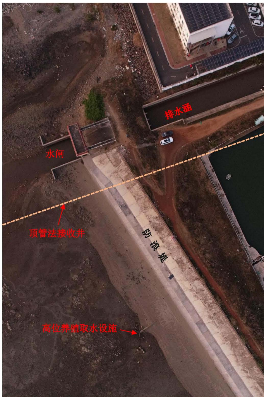
图 5.3.5-1 本项目污水管道下海点航拍照片
