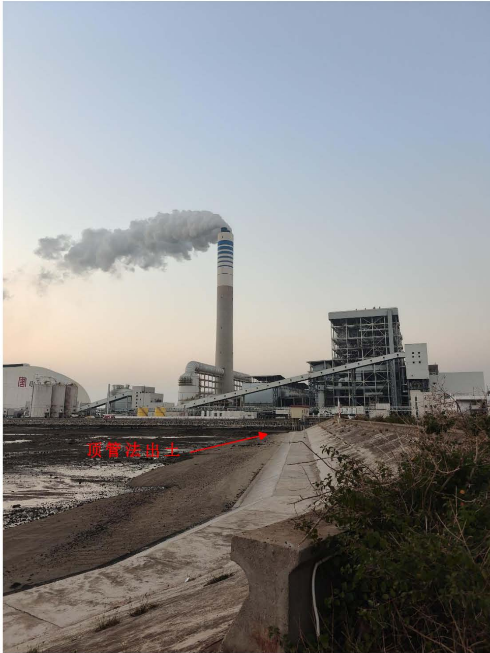
图 5.3.5-2 本项目污水管道下海点处防浪堤照片
