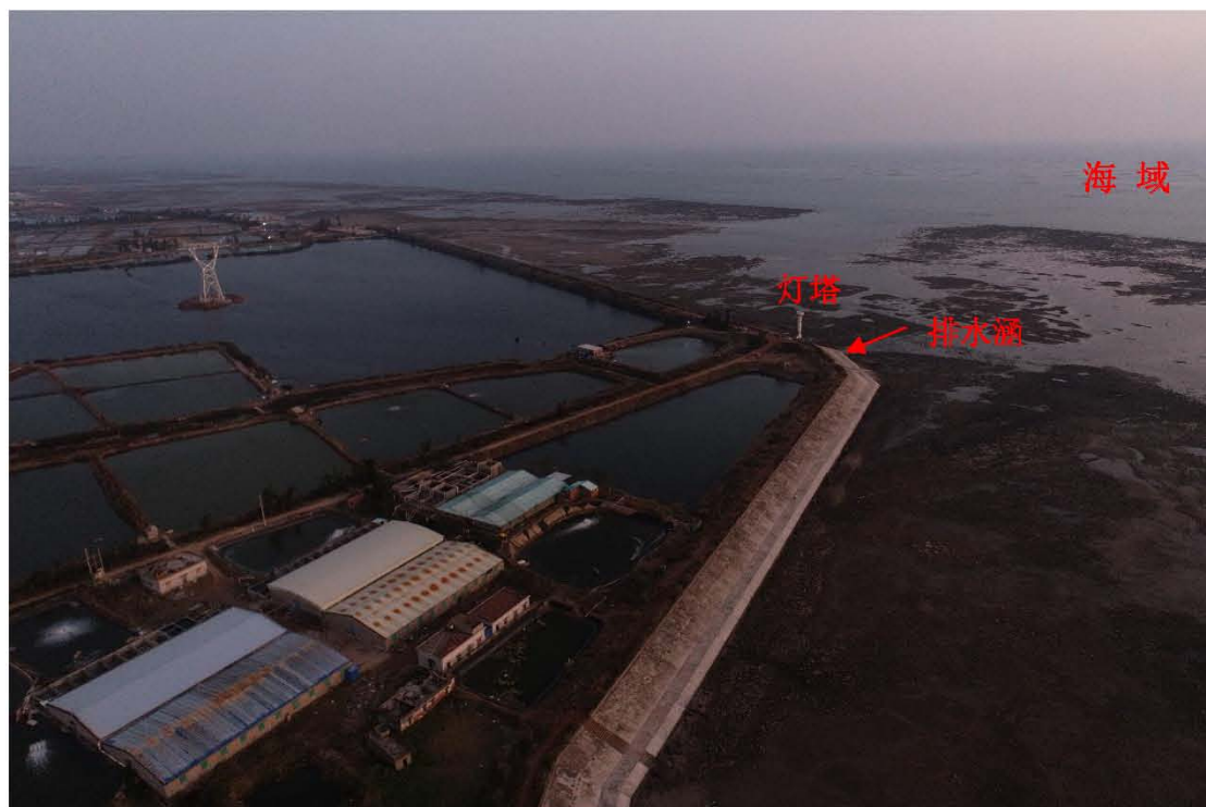
图 5.3.5-4 本项目污水管道下海点南侧航拍照片
