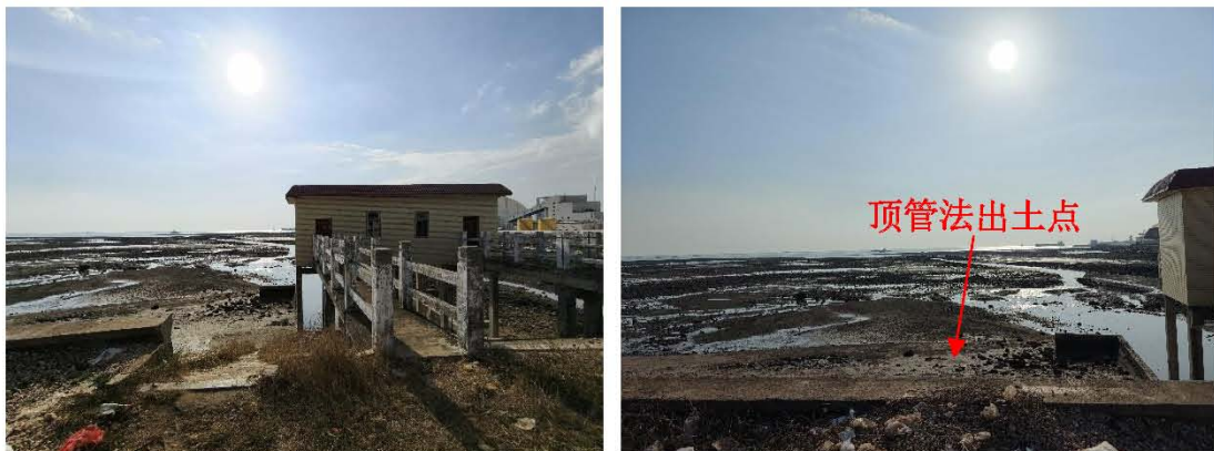
图 5.3.5-3 本项目污水管道下海点处排洪闸照片
