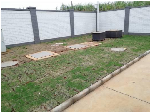
现状升压站事故油池
