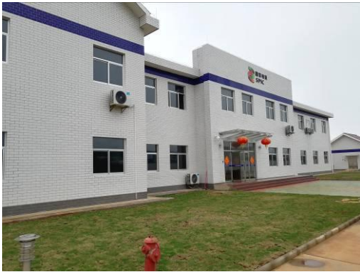
项目已建成 110kV 升压站
