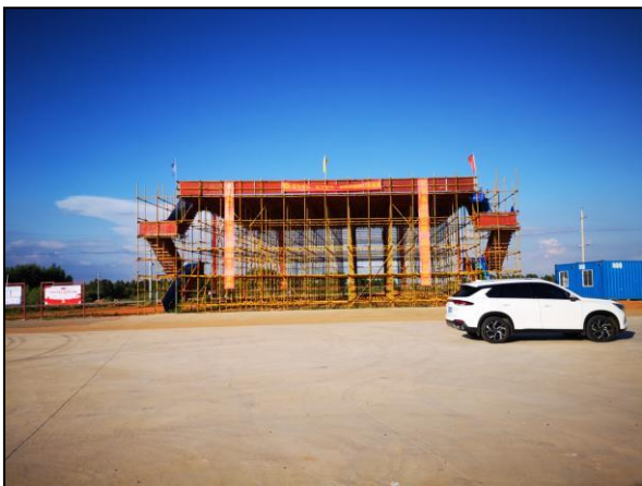
项目现状：钢结构展示台
