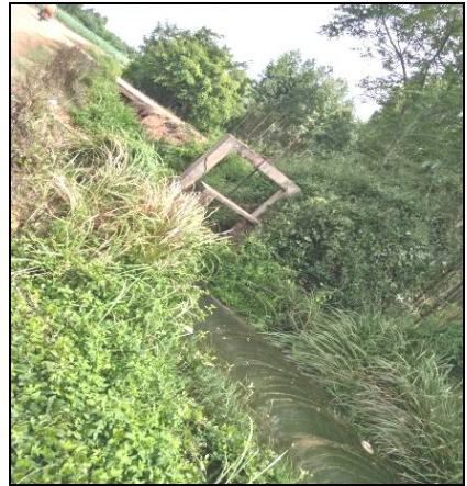
项目现状：豪郎 1 支渠
