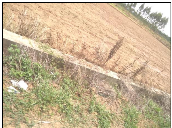
项目现状：部分农渠
