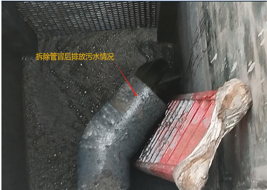
图 8 拆除排污管堵头后污水排放情况
