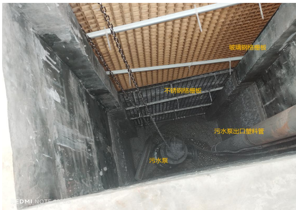
图 7 中转过滤池第二格内部情况
